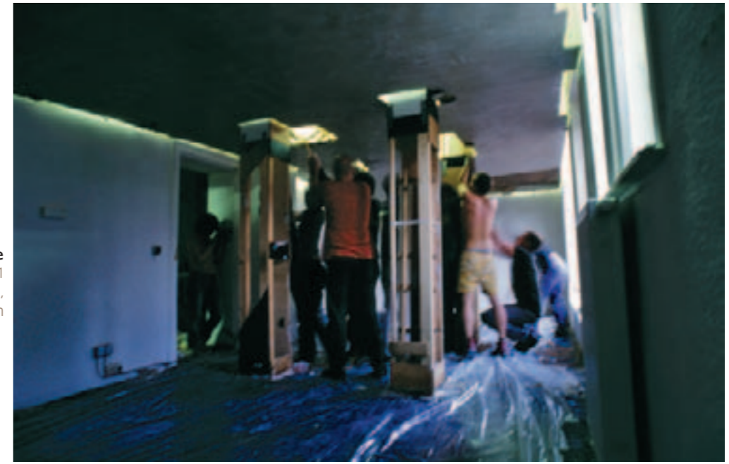
4 a Michael Beutler _ Gipsdecke Dontmiss, Frankfurt/M. 2001 Strohmatte, Seile, Hölzer, Flacheisen, Fertigputzgips 460 x 340 x 820 cm
